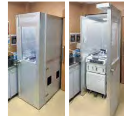
内視鏡洗浄機の稼働音対策 狭小スペースでの作業性を考慮した防音ボックス
