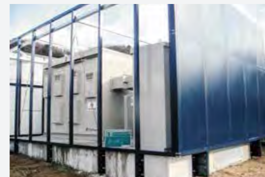
防音壁で設備全体を囲い対策しました。
