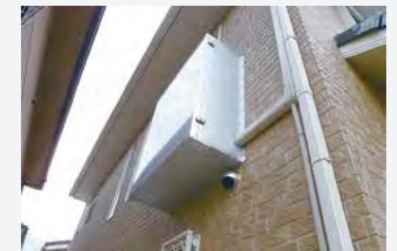
家の外観を損なわない小型防音パネルで対策しました。
