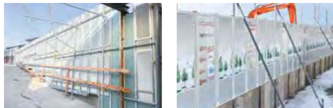
単管パイプで組み上げることができる防音万能塀 工事騒音対策に特化した吸音ガードフェンス
